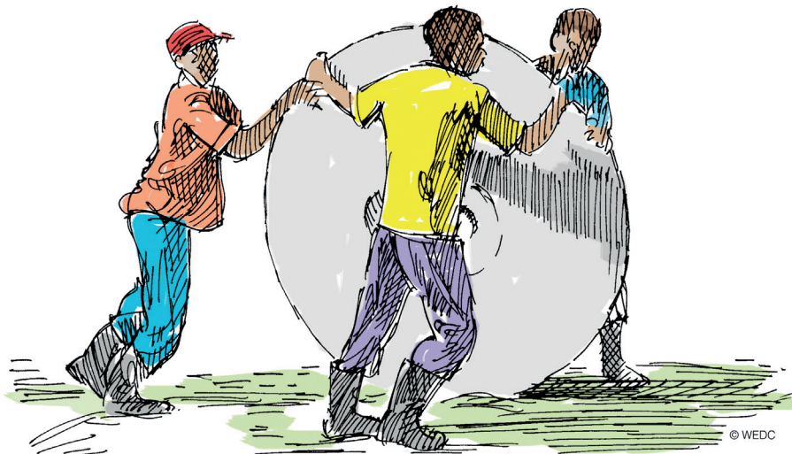
Figure 9. Une dalle de béton circulaire, une fois sèche, peut être déplacée facilement de l'endroit où elle a été fabriquée en la roulant jusqu'à la fosse
